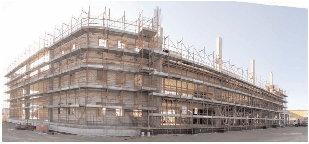
Un' immagine del cantiere della Nuova Sede Amministrativa e Direzione Generale della Banca, a circa 1 anno dall'inizio dei lavori.
